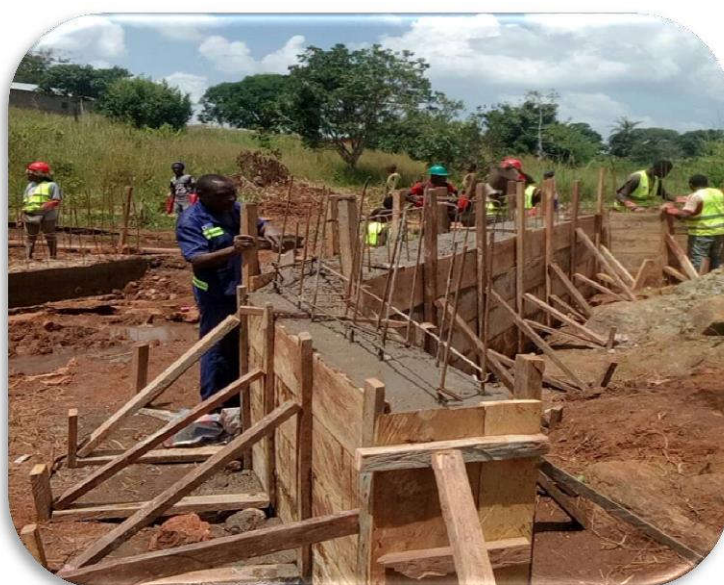
Photo 8 : encadreur et jeunes HIMO en plein travaux de construction du pont de Meiganga
